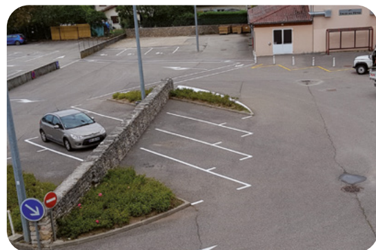
Marquage au sol refait
